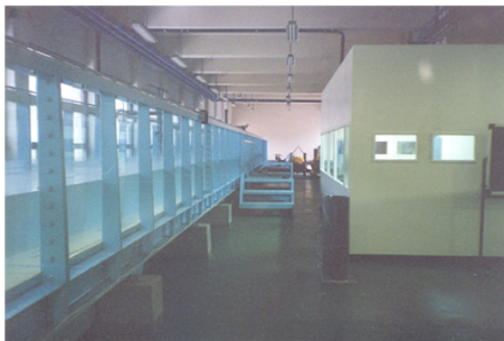
〈중형 단면수조 건설 후 전경〉
