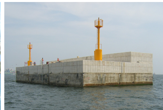
〈석션파일기초 방파제 현장 시험시공〉
