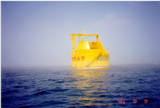
〈60kW급 부유식 진동수주형 파력발전기의 실해역 설치 전경〉
