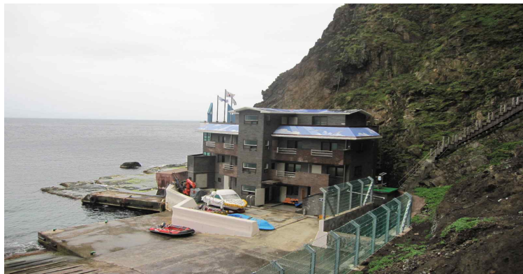
〈낙석방지울타리 설치 전경〉
