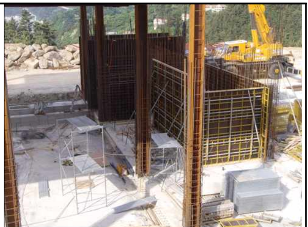
〈 격납고 계단실 거푸집 조립 〉
