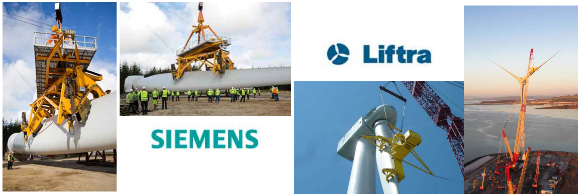
그림 1.6 해상풍력발전기 설치를 위한 특수 리프팅 시스템
