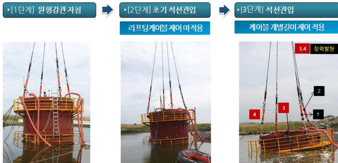
그림 2.46 원형강관 수직도보정 실험과정 (test 1)
