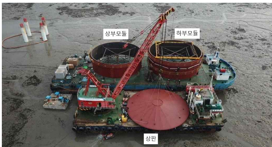
그림 3.24 원형강관 가설공법 테스트베드 전경
