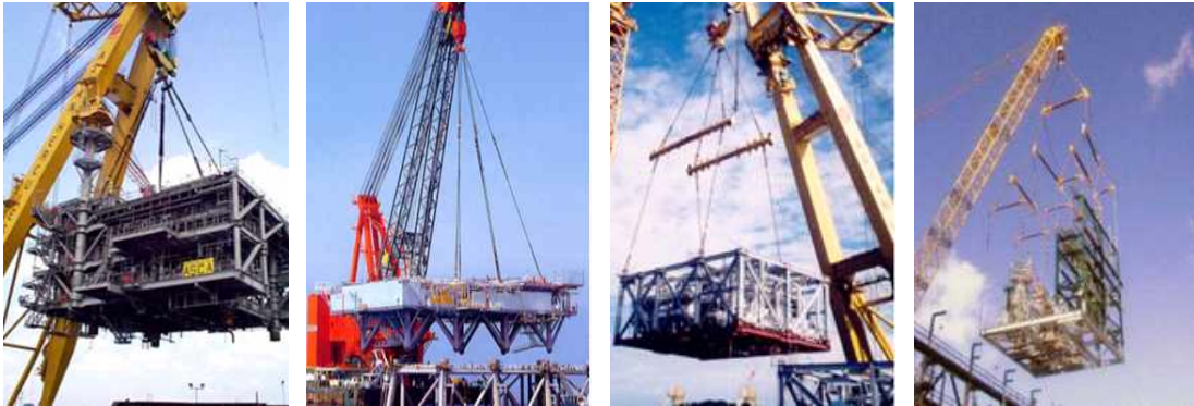
그림 1.4 리프팅 바와 슬링을 이용한 해양구조물의 리프팅 모습 (Li, 2004)
