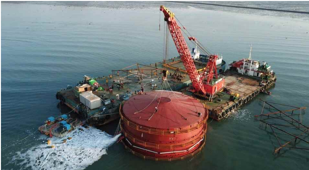
그림 3.26 테스트베드 원형강관 석션관입 시공
