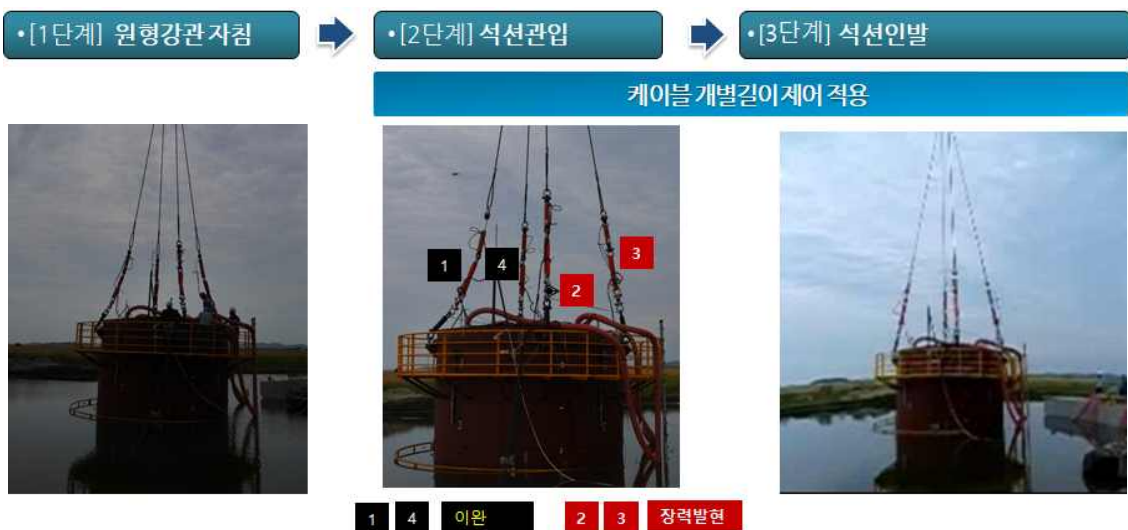
그림 2.50 원형강관 수직도보정 실험과정 (test 2)
