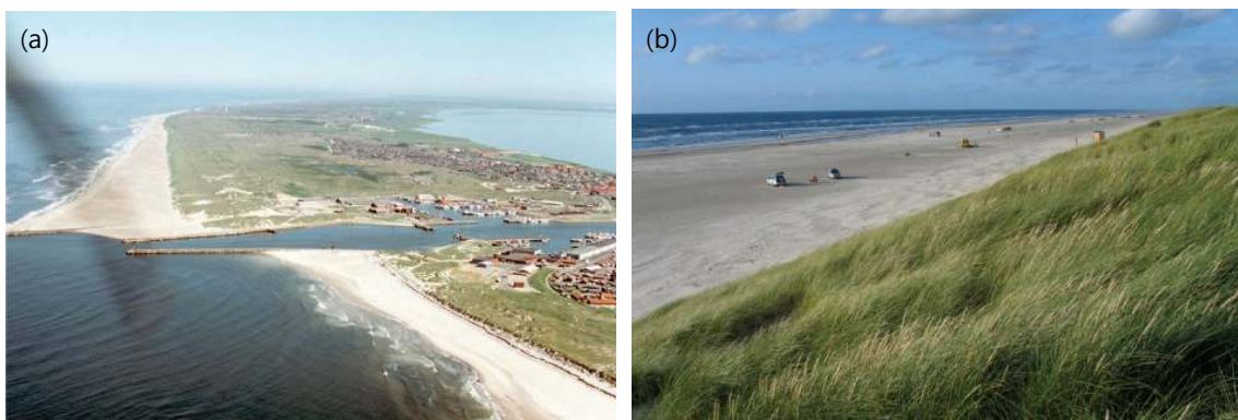
그림 A11.2 (a) 어항 접근항로 확보를 위한 도류제 표사하류 침식(Hvide Sande); (b) 사구식생(Vejers Strand) 147)
