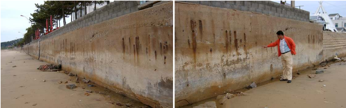
그림 4.1.5 고조폭풍에 의한 만리포해수욕장 호안전면 침식 (촬영일시 2007/05/21 09:58)
