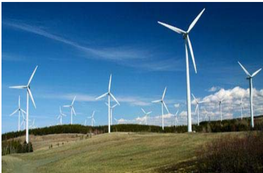
그림 2.23 Iowa Stored Energy Plant
