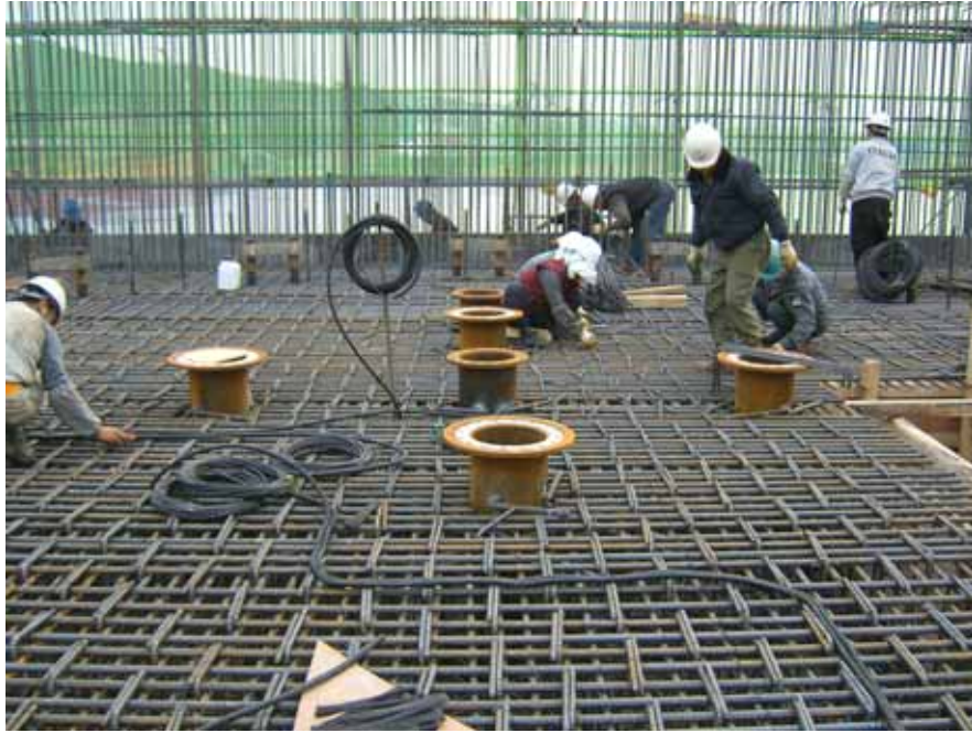
석션펌프 배관 및 공기배출구 설치
