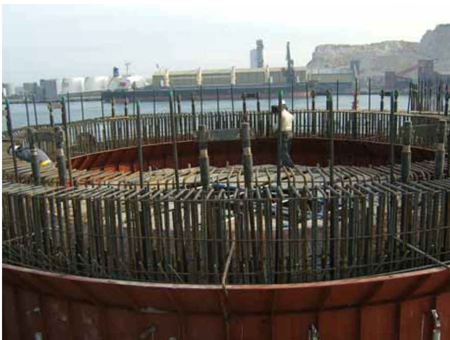
그림 3.2.15 현치거푸집 설치
