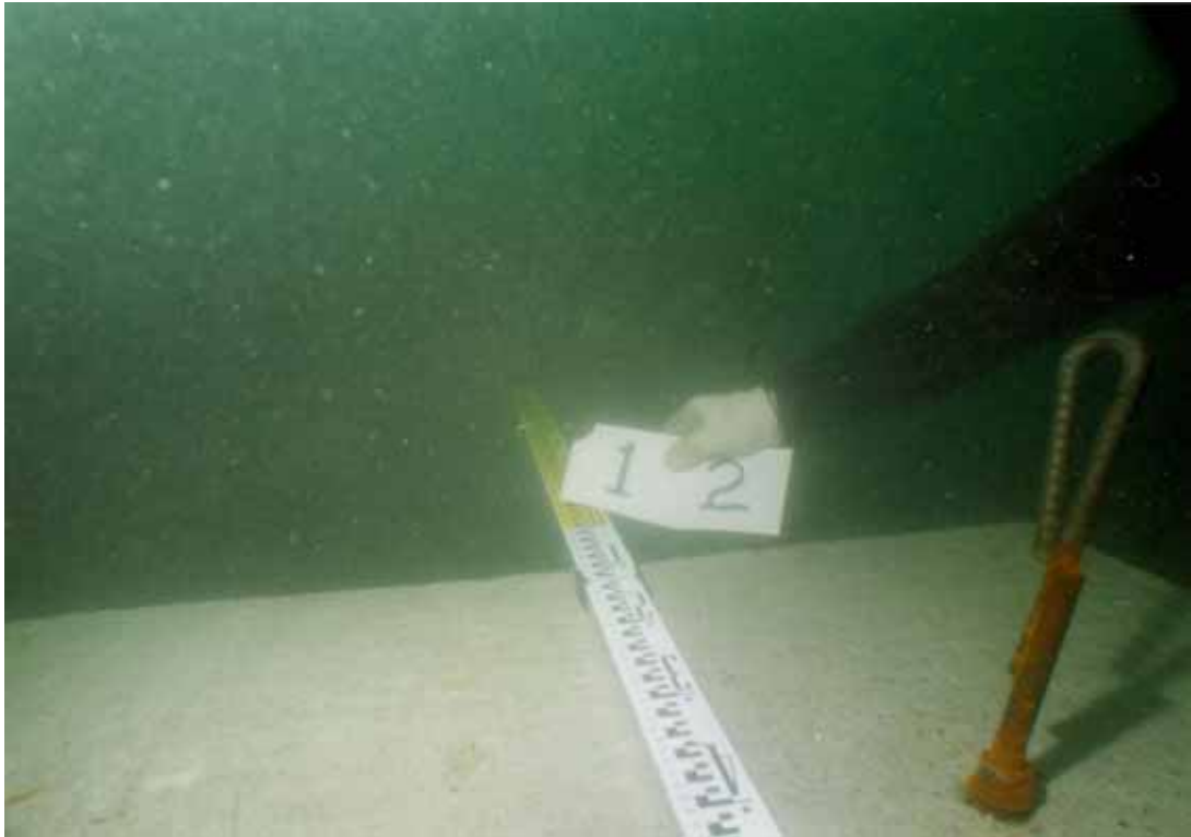
그림 3.3.4 석션파일 거치 후 모습-1
