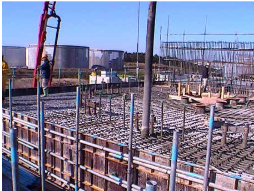
그림 3.2.17 슬래브 측면 유로폼 설치
