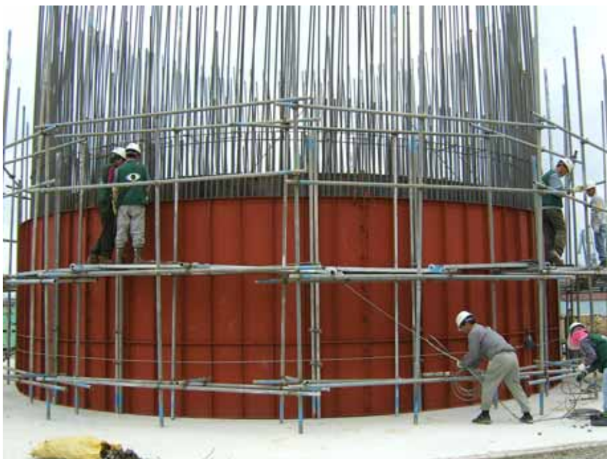
그림 3.2.9 벽체거푸집 설치
