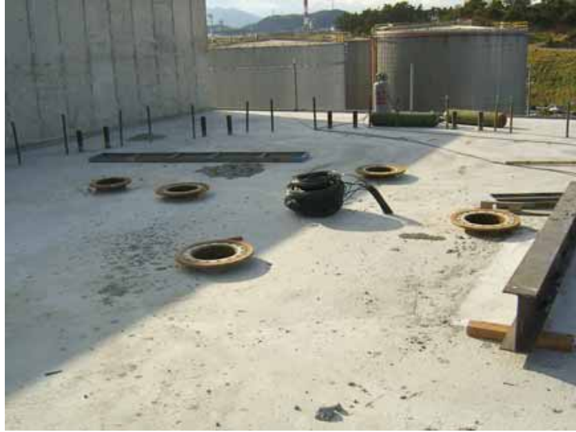
그림 3.2.22 석션펌프 Flange 설치
