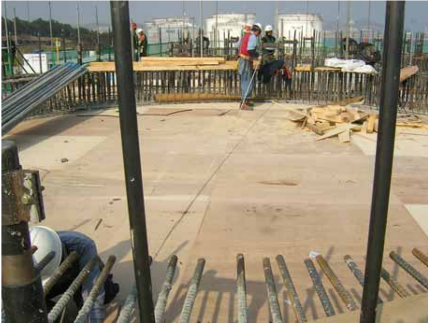
그림 3.2.16 슬래브 저판 거푸집 설치
