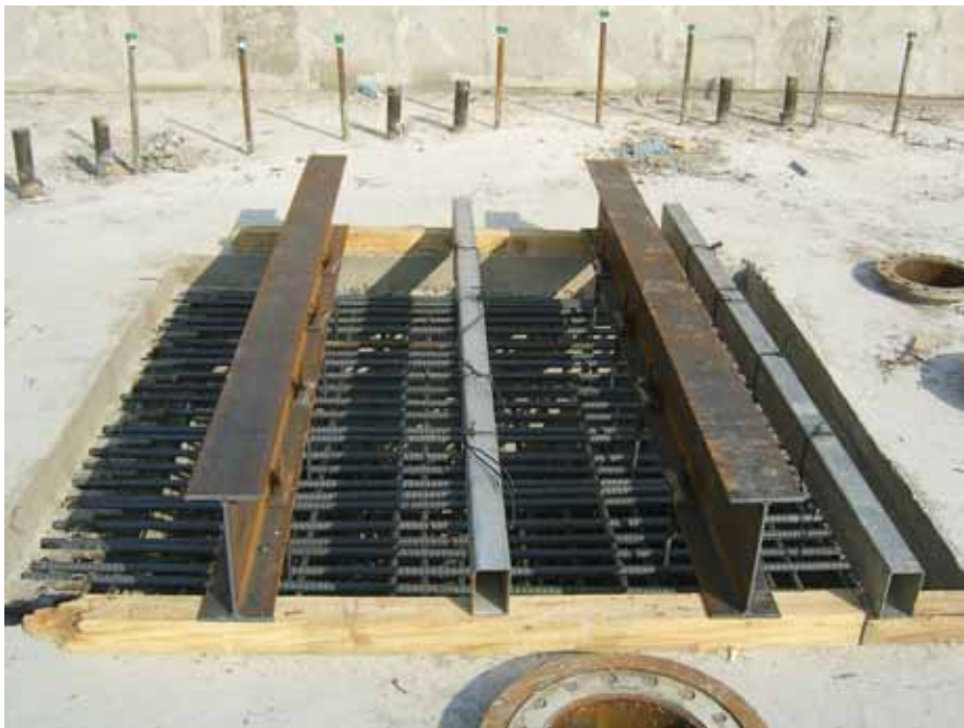
그림 3.2.24 작업용개구부 설치
