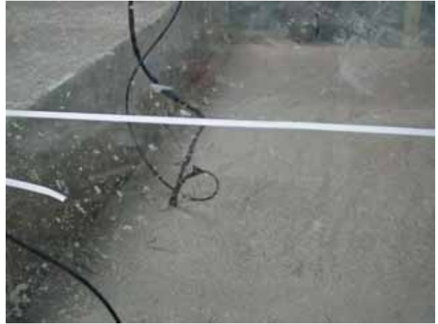
그림 4.2.10 모래지반에 설치된 간극수압계
