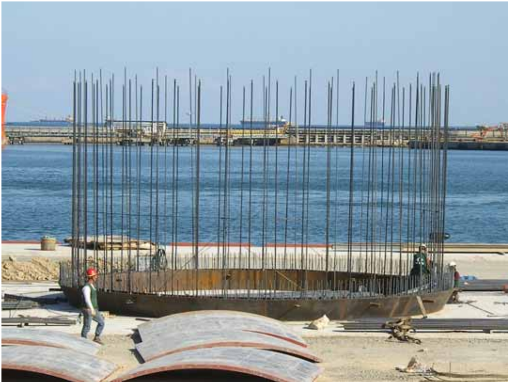
그림 3.2.5 Shoe 설치
