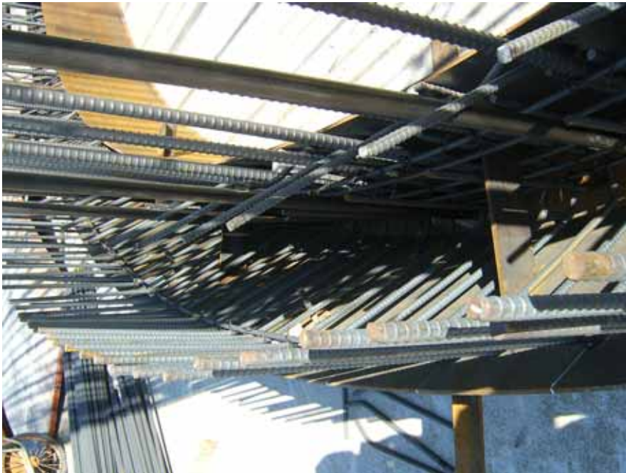
워터제트 노즐 및 지지철근 조립
