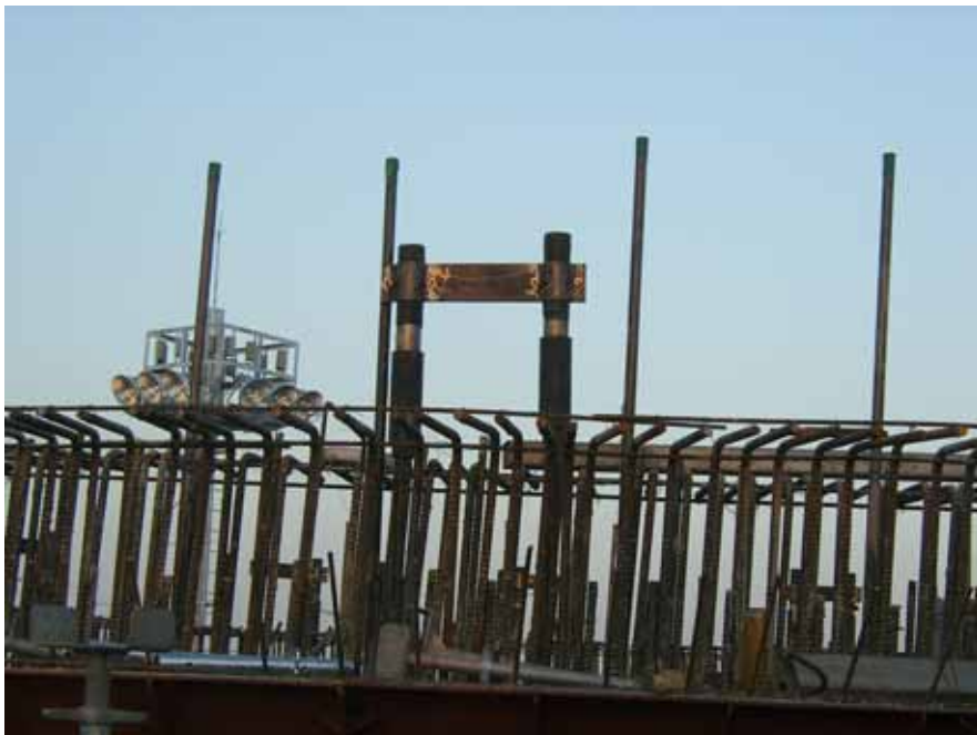
그림 3.2.11 들음고리 설치
