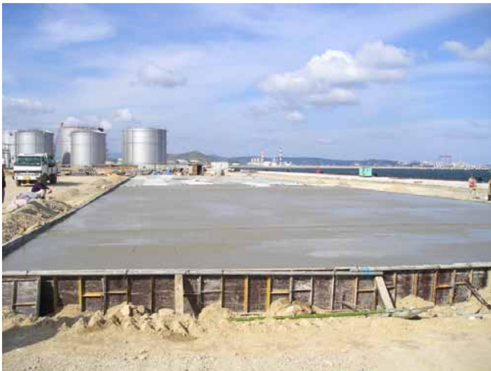
그림 3.1.6 제작장 콘크리트 타설
