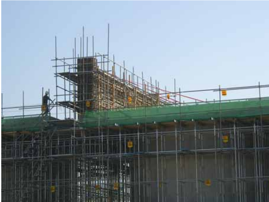
그림 3.2.25 전단벽 유로폼 설치
