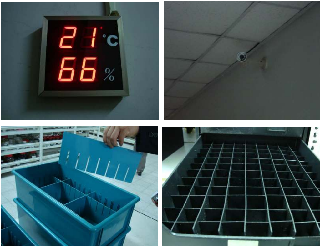
그림 2-5. 수장고내 디지털 온도, 습도 표시장치(좌측) 및 감지기(우측).
