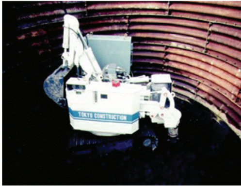
[대심도 굴착 공사 로봇]
