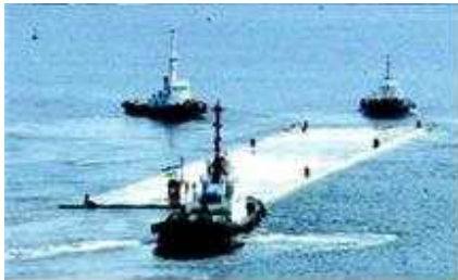
해저 침매터널 공사
