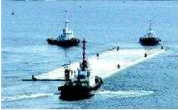
(a) 해저 침매터널 공사
