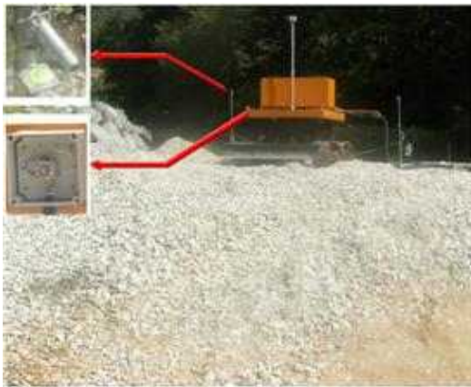
(a) 설치된 초음파 센서
