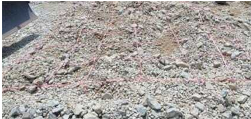
그림 2.1.2 측정 그리드 설치
