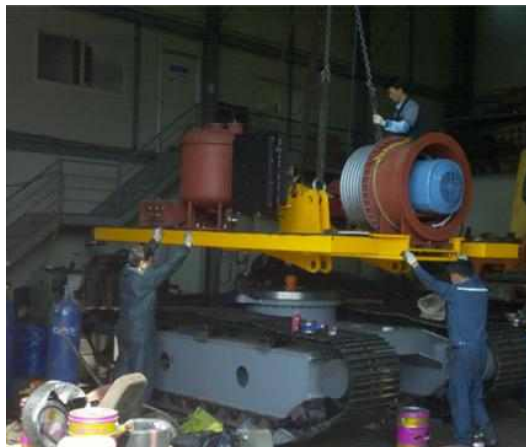
그림 2.2.18 상부/하부 플랫폼 조립
