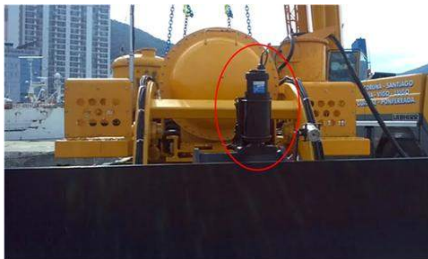
그림 3.2.2 Hammer Head Sonar entrained on rock paver
