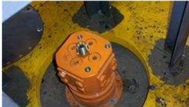
(a) 센터조인트 설치
