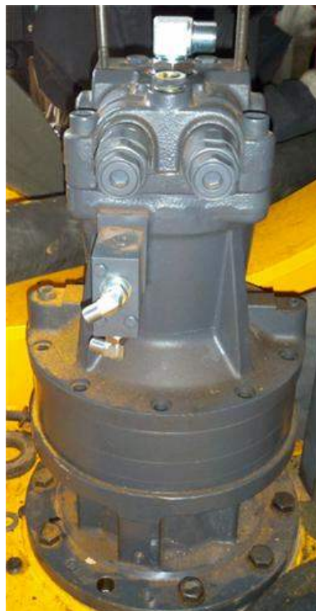
(b) 스윙 모터 및 감속기 설치
