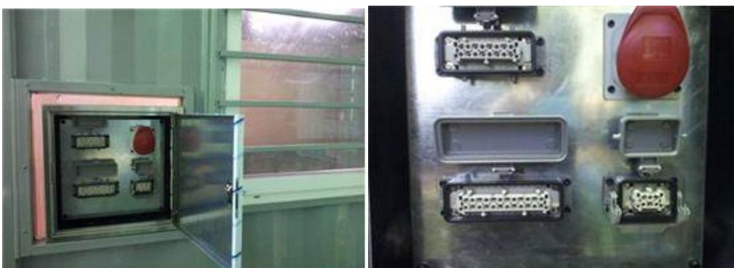
그림 4.1.3 전원 및 통신케이블 인입부 설계 1차 안
