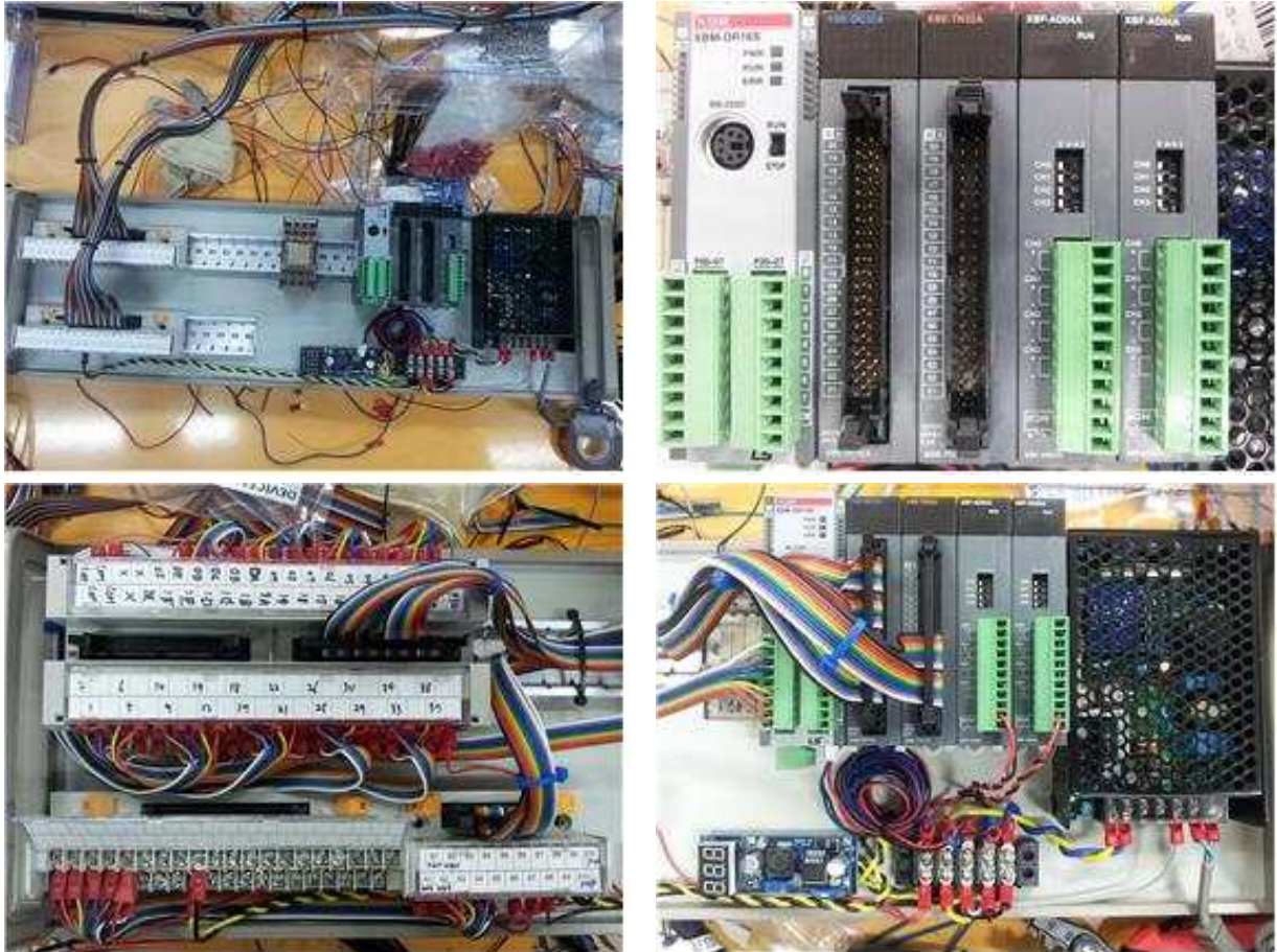
그림 4.2.9 제어패널의 PLC 제어부 제작 및 배선작업
