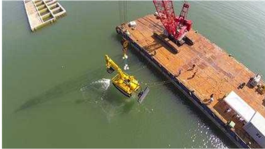
그림 5.2.13 실제 사석고르기 현장에서 수중실험 후 출수하는 장비
