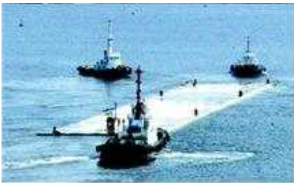
(a) 해저 침매터널 공사
