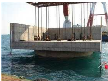
(b) 석션파일 기초방파제 시공현장
