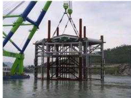
(f) 울돌목 시험조류발전소 시공
