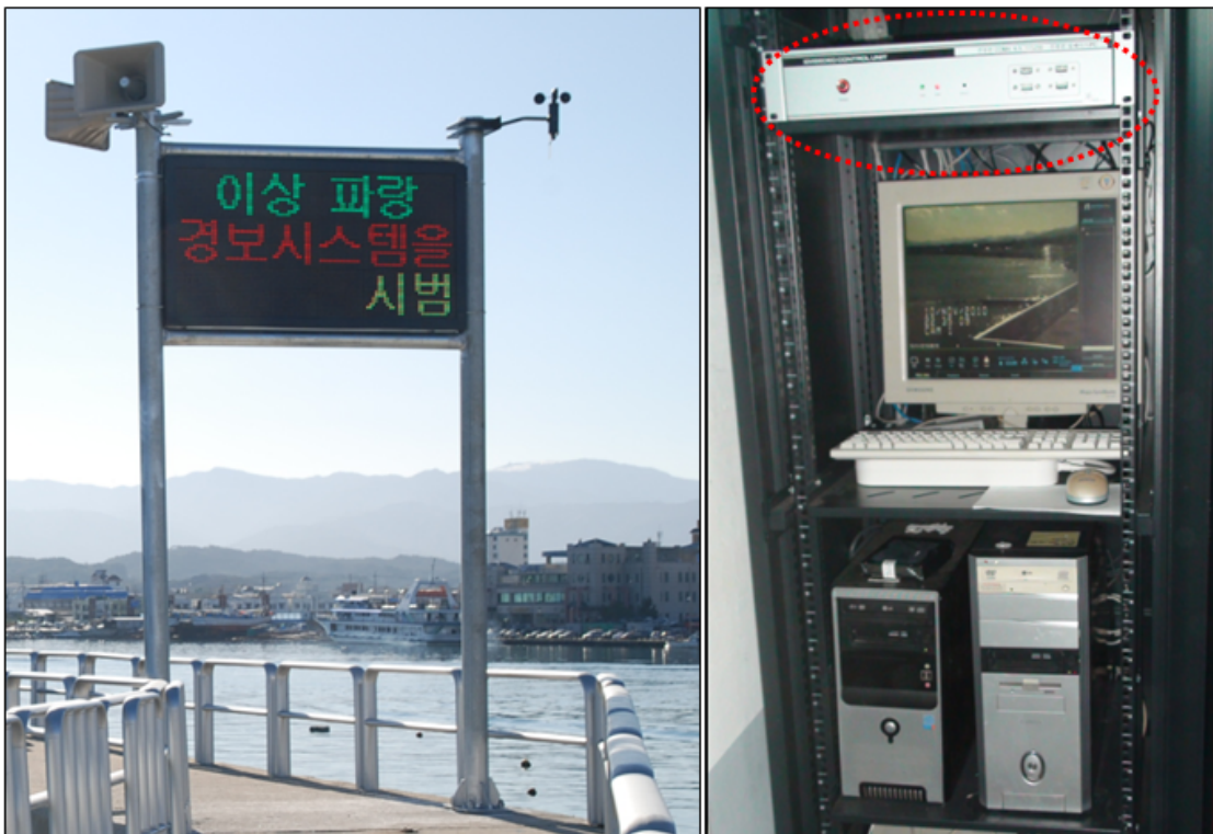
그림 3-9. 월파 예경보 표출 장치 (왼쪽) 및 제어장치 (오른쪽)
