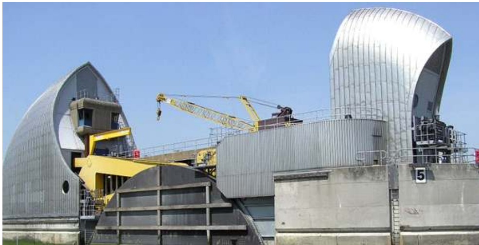
<그림 2.18> Thames Barrier 근경 (수문 폐쇄 시)
