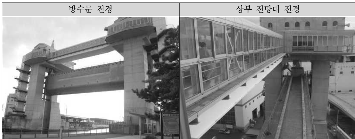
〈그림 2.10〉 누마즈(沼津)항 방수문 및 상부 전망대 전경(유신기술회보, 2012)
