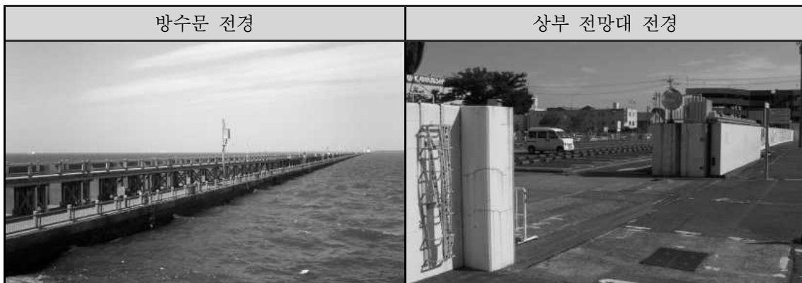
〈그림 2.11〉 나고야 방수문 및 상부 전망대 전경(유신기술회보, 2012)
