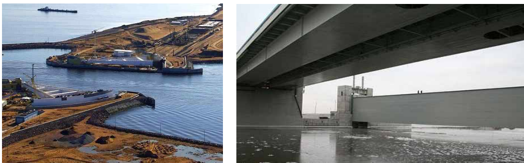
〈그림 2.21〉 건설 중인 St. Petersburg Flood Barrier 전경
