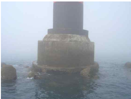
현장 실태조사 사진
