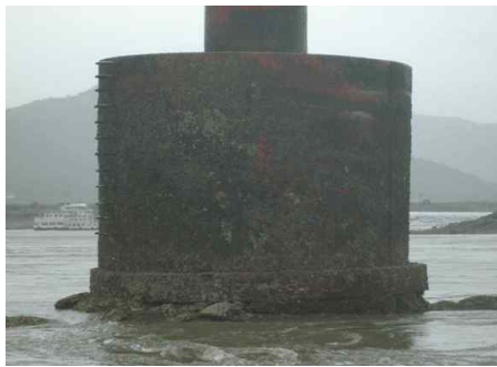
현장 실태조사 사진
