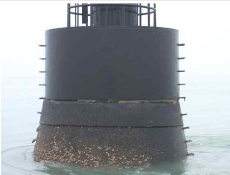
현장 실태조사 사진
