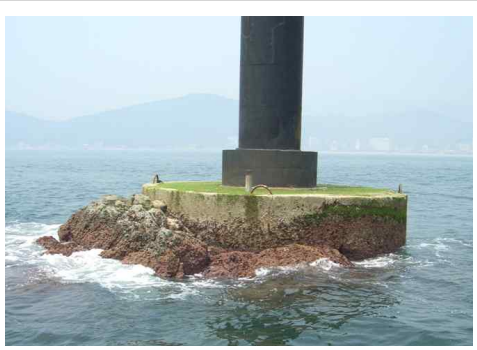
현장 실태조사 사진
