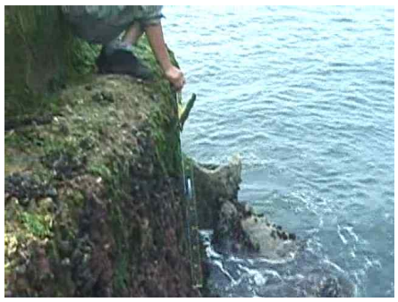
현장 실태조사 사진
