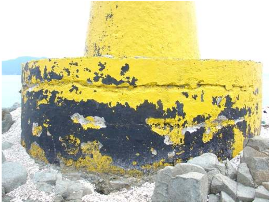
<그림 3-2-9> 여초 등표 현장조사 사진 - 세굴상태(북향)
