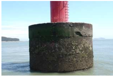
현장 실태조사 사진
