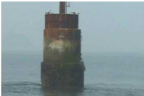
현장 실태조사 사진
