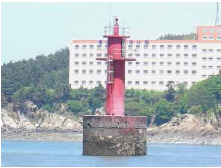
현장 실태조사 사진
