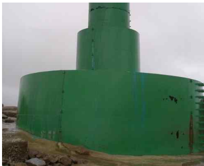
현장 실태조사 사진
