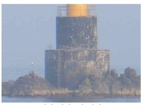
현장 실태조사 사진
