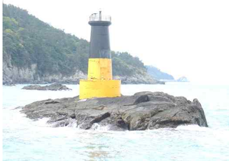
현장 실태조사 사진
