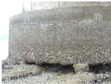
현장 실태조사 사진
