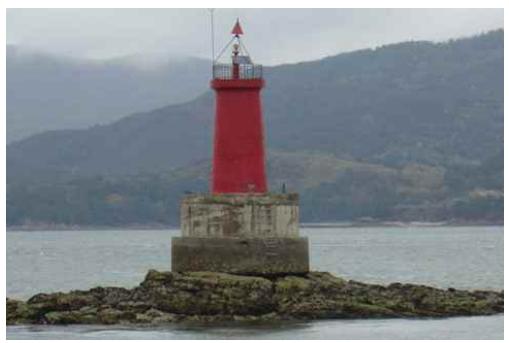
현장 실태조사 사진
