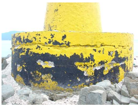
현장 실태조사 사진
