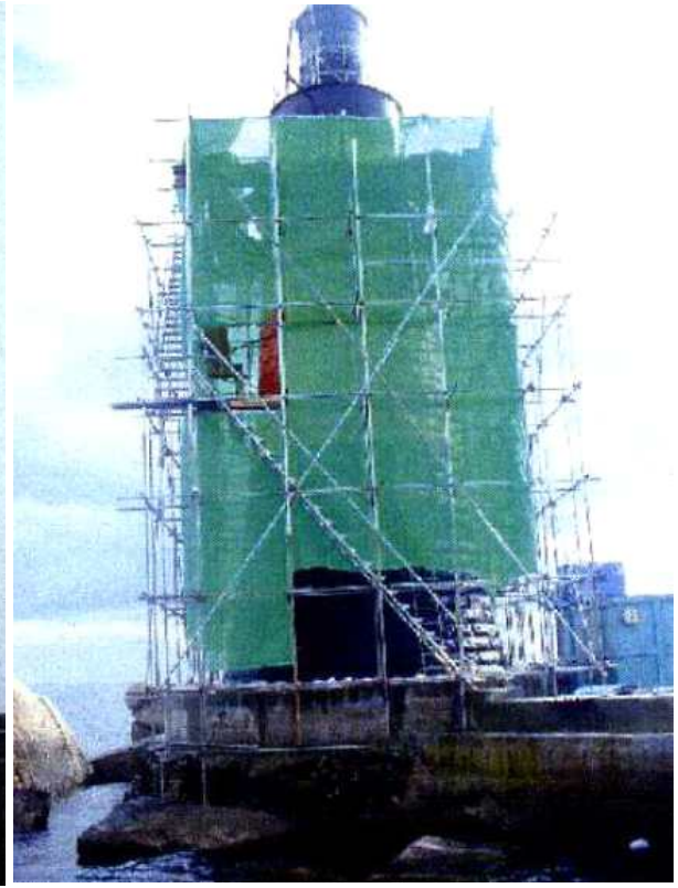
<그림 2-2-3> 安藝白石 등표의 보수보강 모습
