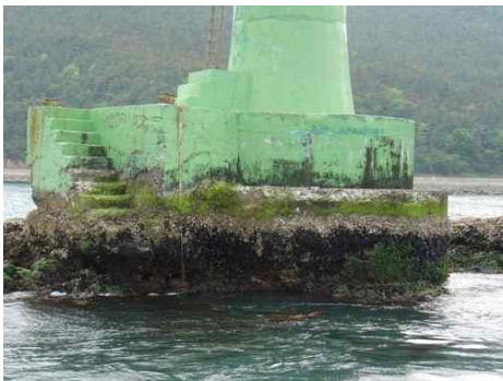
현장 실태조사 사진
