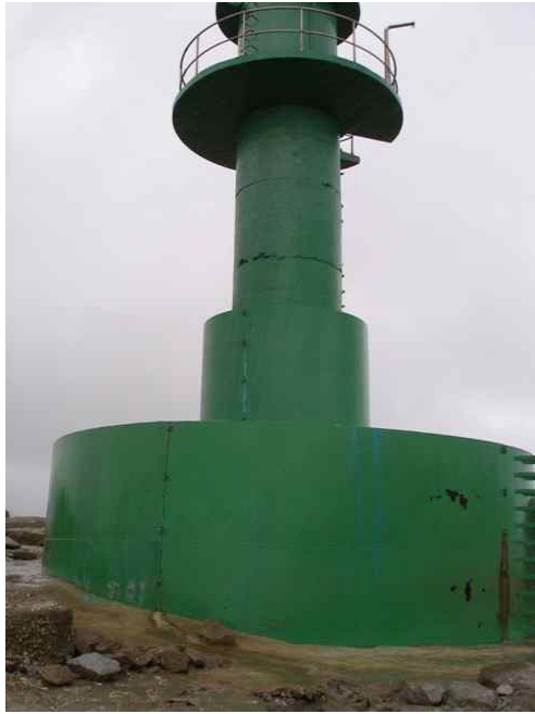
<그림 3-2-13> 보수·보강 후 작은구들돌 등표 현장조사 사진 1
