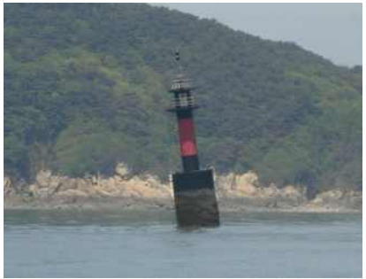
현장 실태조사 사진
