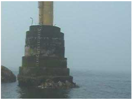
현장 실태조사 사진
