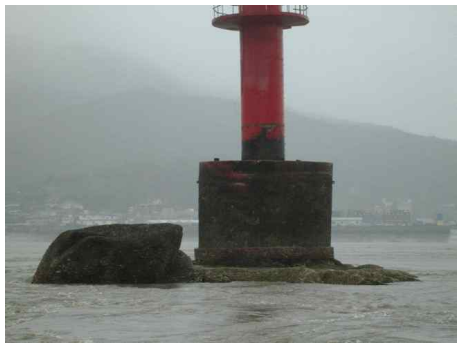
현장 실태조사 사진
