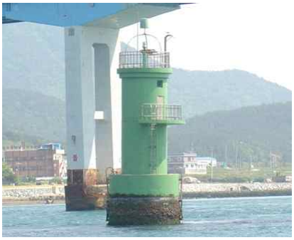
현장 실태조사 사진
