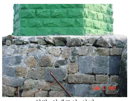
현장 실태조사 사진
