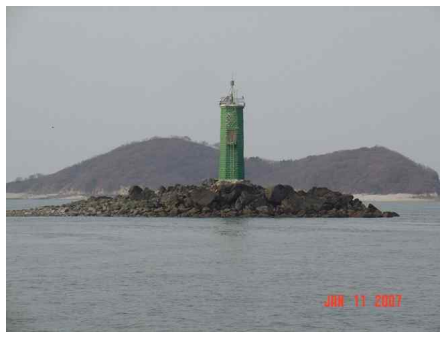
현장 실태조사 사진
