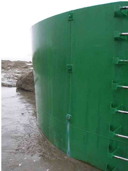
<그림 3-2-14> 보수·보강 후 작은구들돌 등표 현장조사 사진 2
