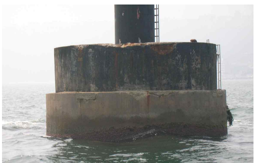
현장 실태조사 사진
