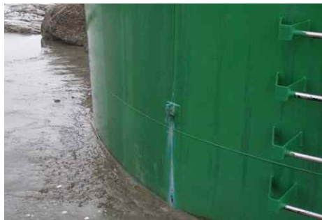
현장 실태조사 사진
