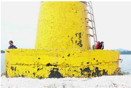
현장 실태조사 사진
