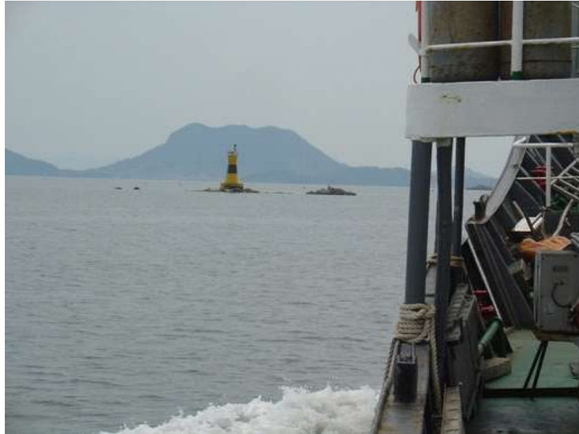
<그림 3-2-5> 여초 등표 현장조사 사진 - 등표 전경
