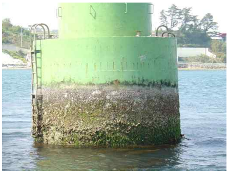
현장 실태조사 사진
