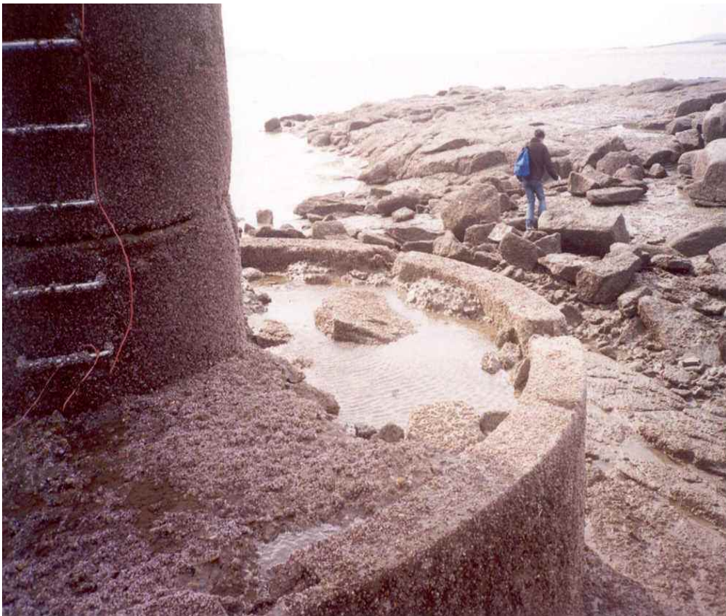
<그림 3-2-12> 보수·보강 전 작은구들돌 등표의 현장사진
