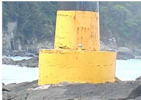
현장 실태조사 사진
