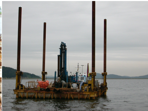
〈SEP barge 위에서 수행중인 해양콘관입시험〉
