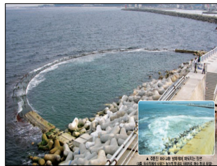
〈해수교환 방파제 완공 현황(주문진항)〉
