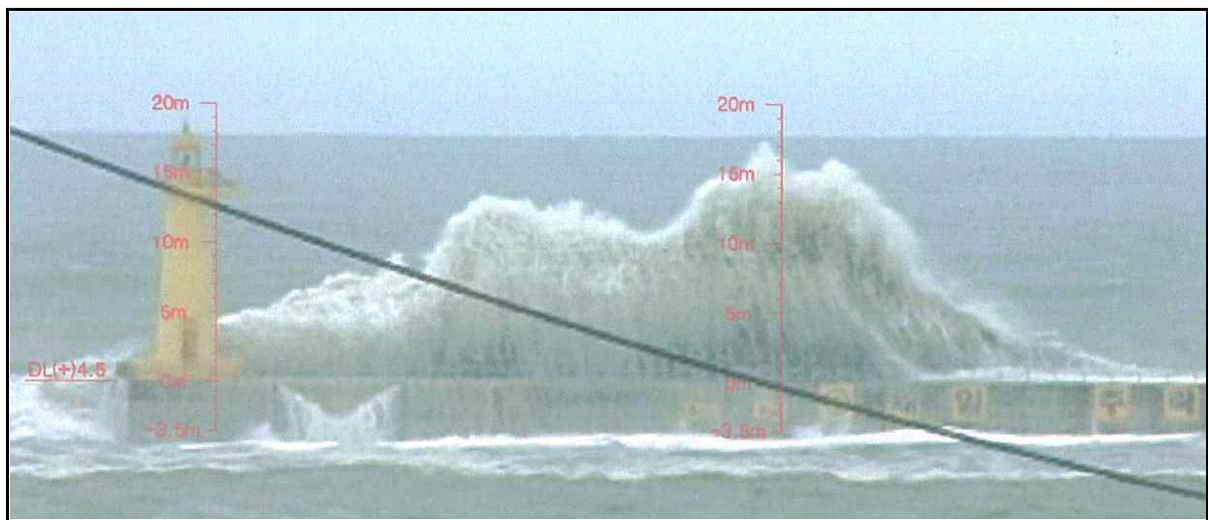
<그림 2.1.8> 포항 영일만 태풍 나비 내습 전경사진
