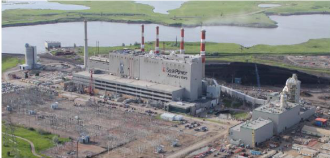
<그림 4.7> Boundary Dam 이산화탄소 포집 플랜트
