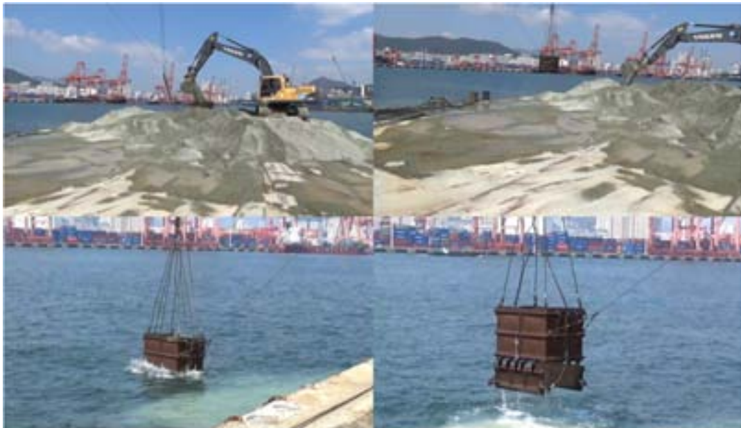
[그림. V-라-3] 실제 시공 과정
