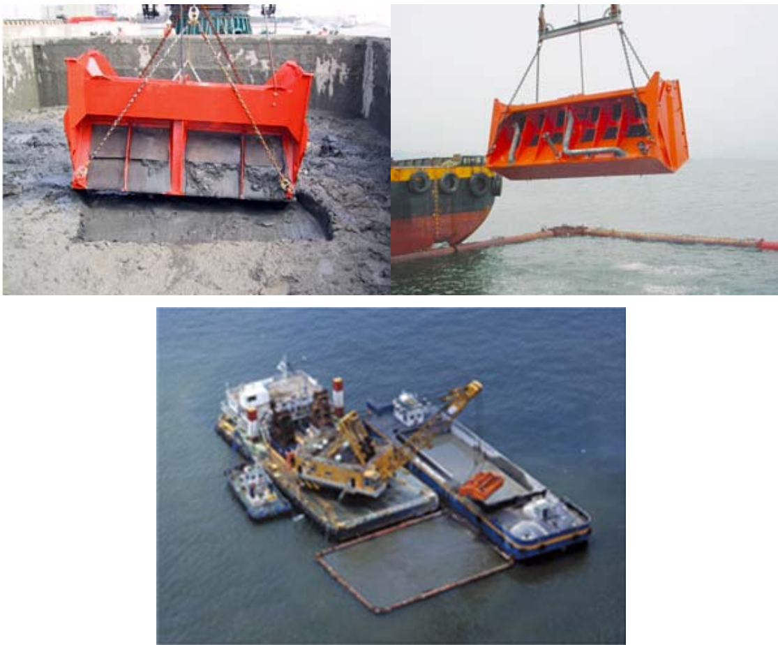
[그림. I-라-33] 소형 이동식 오타방지막과 밀폐형 그랩에 의한 준설
