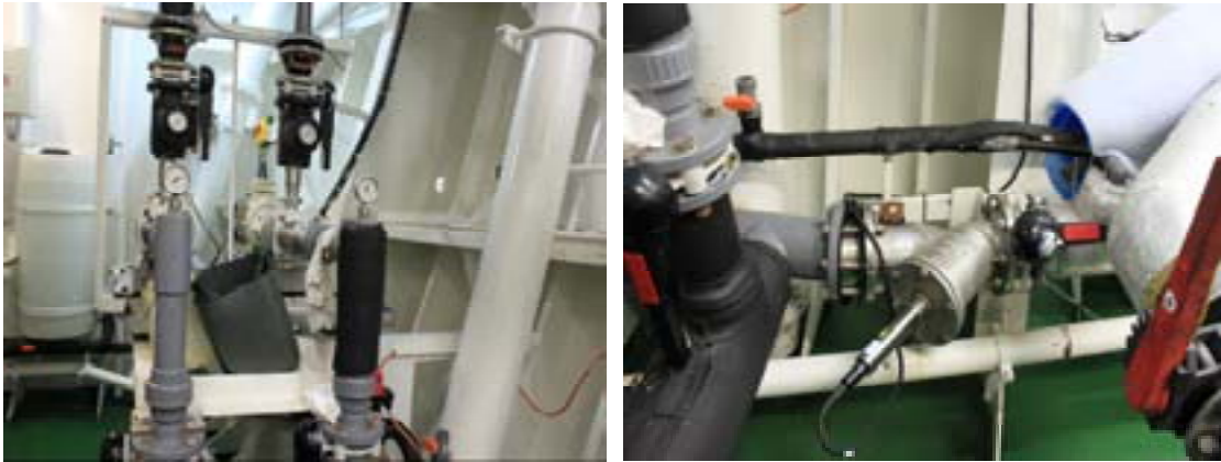
<그림 6-13> 해수 초입단 관측센서 설치
