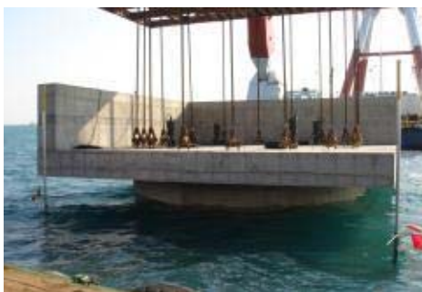
[석선파일 기초방파제 시공현장]
