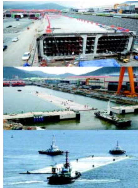
[해저 침매터널 공사 현장]
