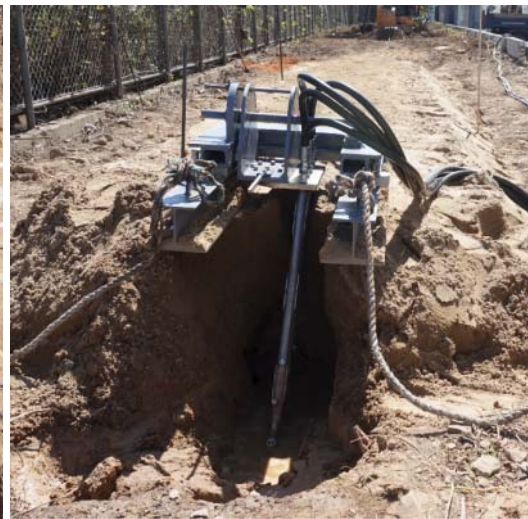
실험대차 및 Jetting arm
