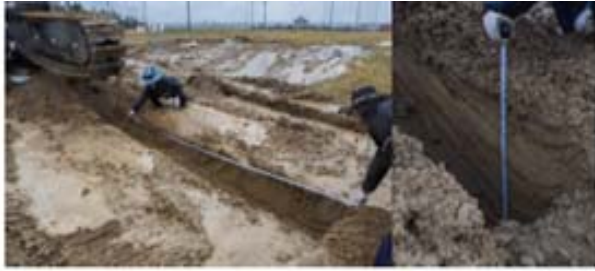
<트랜칭 깊이 0.9m 측정>
