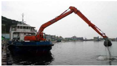
<중장비를 활용한 부유쓰레기 제거 작업>
