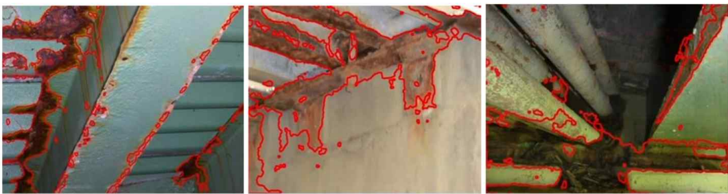
<그림 5-10> 교량 하부의 부식 모니터링 결과 및 가시화(Wu and Kalfarisi, 2019)
