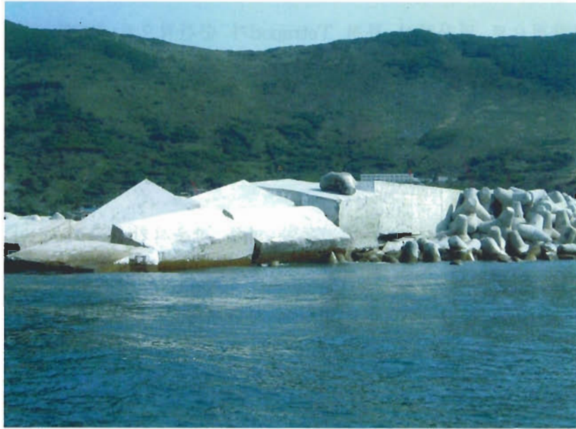
<사진 3.3.1> 12호 태풍 프라피룬의 영향으로 제두부에서 발생한 64톤급 Tetrapod 및 상치구조물의 피해 장면
