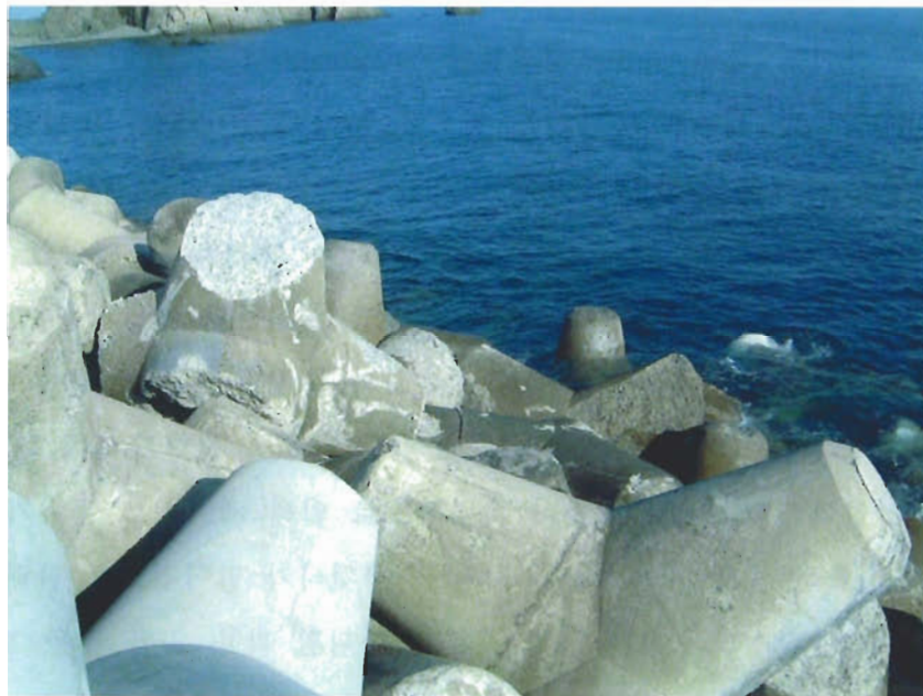
<사진 3.3.2> 12호 태풍 프라피룬의 영향으로 제간부에서 발생한 64톤급 Tetrapod의 피해 장면
