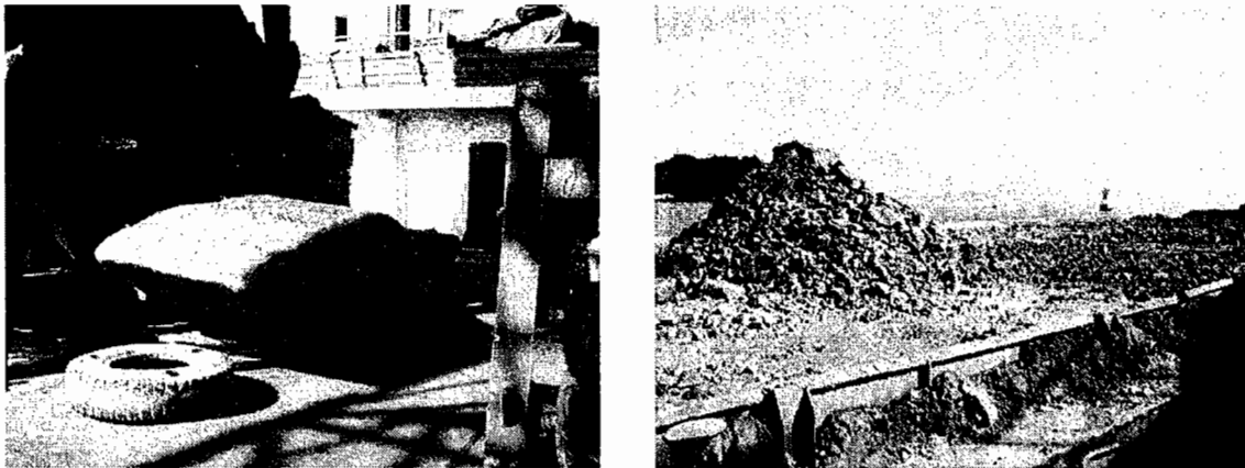
그림 3.1.20 GG2 그랩 준설시의 쇄암봉(좌) 및 쇄암후 준설암편(우).
