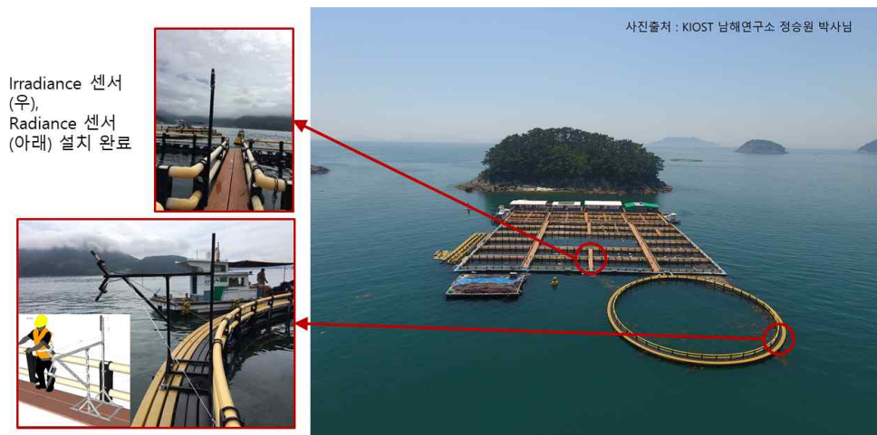
그림 158. 한국해양과학기술원 통영해상과학기지에 설치한 초분광 센서
