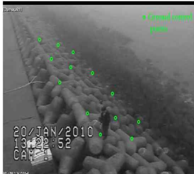
(a) 방파제 지상기준점의 측정
