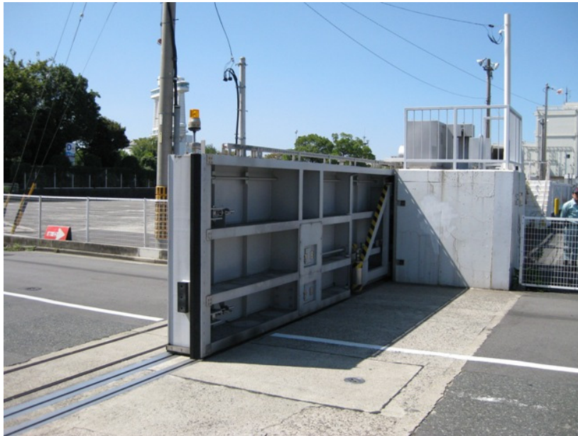
Fig. 10.1.9. Inundation Protection Wall of Nagoya
