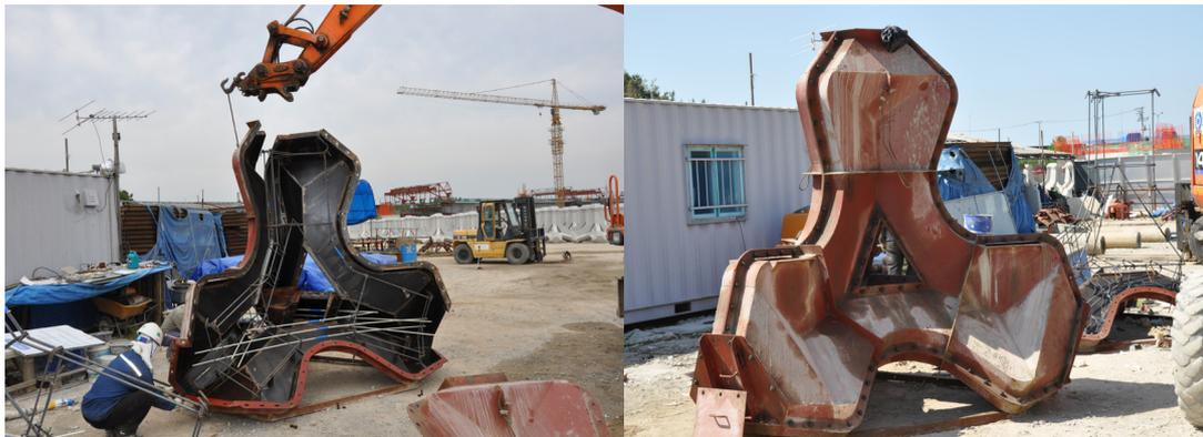
그림 3.2.5 소파블록 폼 설치
