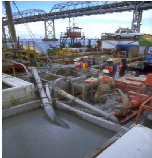
<그림 3-24> Mud Circulation System
