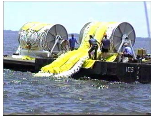
그림 3.3.29 Hydro RIB 실험역 설치 모습
