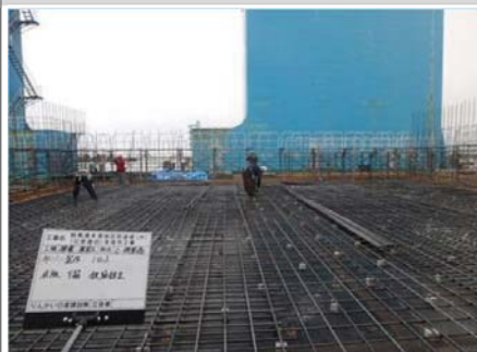
5. 기초철근 및 레미콘 타설
