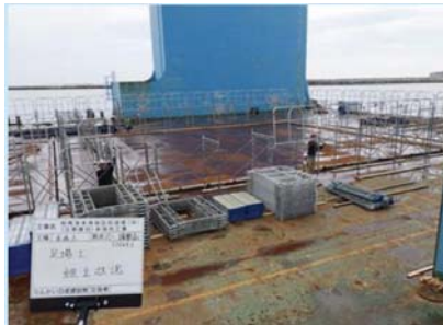
1. 외곽 가이드 목재 설치
