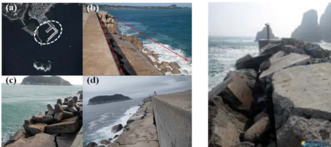
<그림 3> 대형 태풍에 의한 방파제 피해상황.
