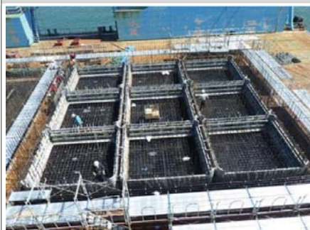
6. 벽체 철근 및 레미콘 타설
