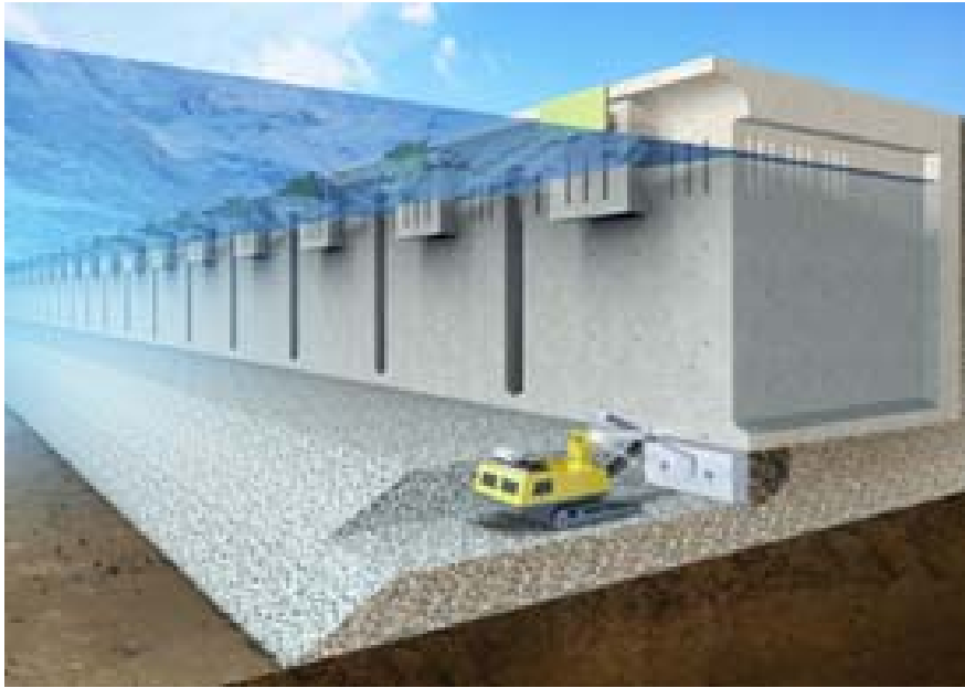
부록 그림 6 수중건설로봇을 이용한 안벽 하부사석의 보강
