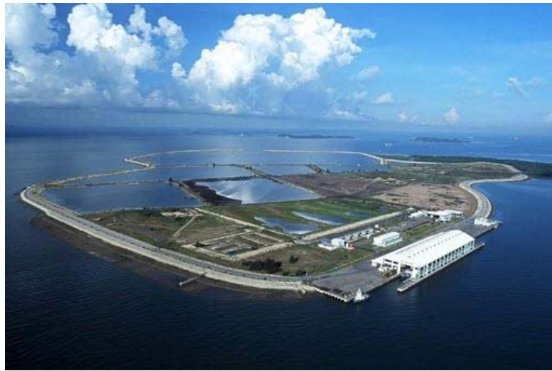
그림 2.2.7 싱가포르 세마카우 해상최종처리장 전경
