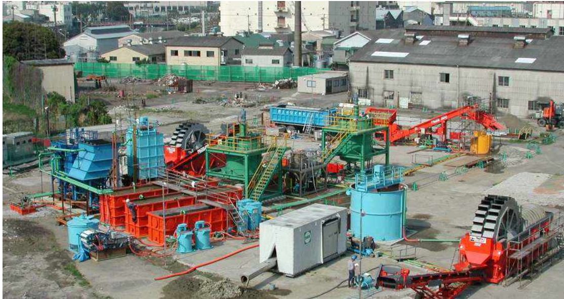
그림 2.2 BioGenesis사의 토양 퇴적물 세척 장치
