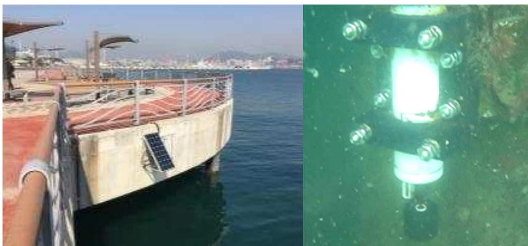
[그림 3-10] 부산 영도 신청사 실시간 해양관측 시스템
