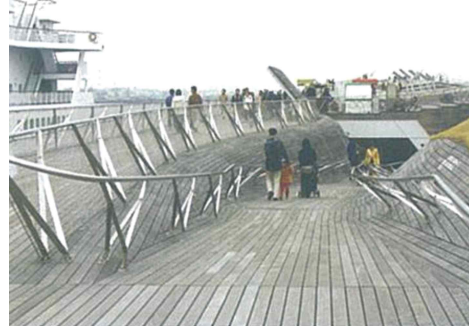
내부 터미널로 내려가는 램프
