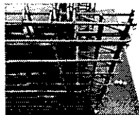
철근 조립 및 콘크리트 타설
