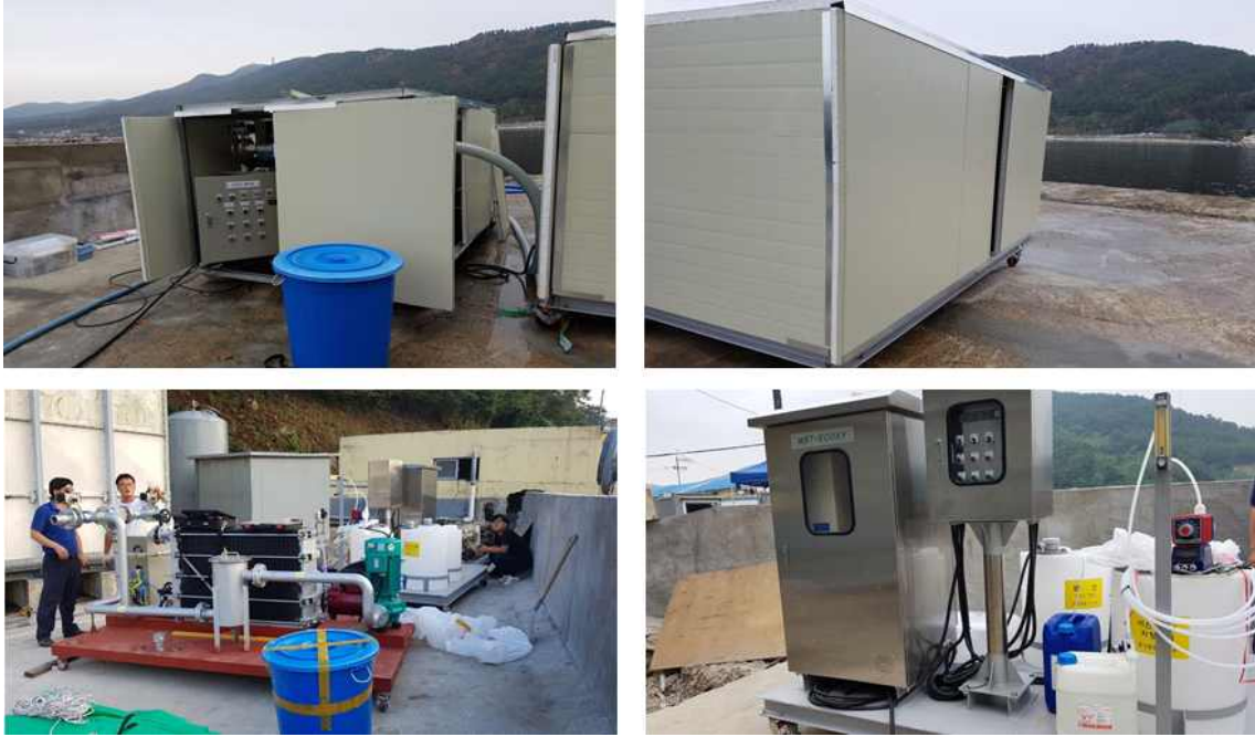
그림 17. 이산화염소 발생장치와 구조토 미세막 여과기 통영 현장설치 완료
