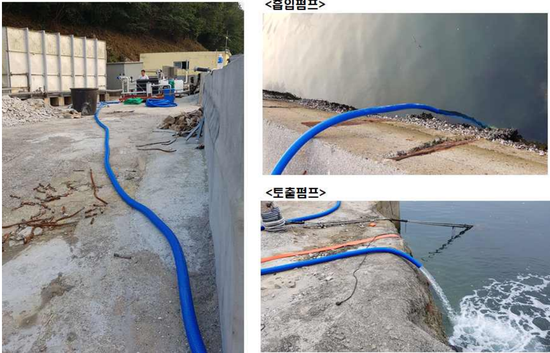
그림 19. 통영지역 시험 가동 중
