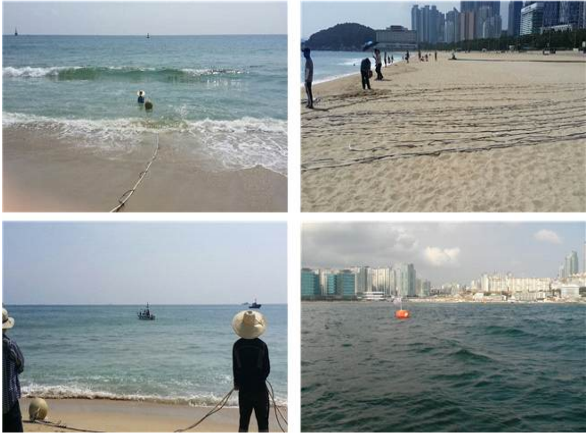
그림 34. 파고 케이블의 설치 사진
