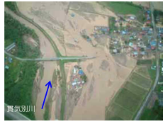
図4.2.1 沙流川上流部（賀気別川コタン橋付近）
