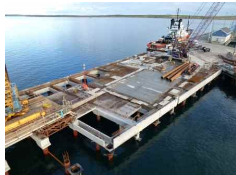
그림 3.16 신형식 잔교공법을 이용한 부두 건설
