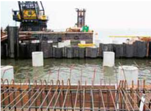
그림 3.15 내해수강 말뚝을 이용한 항만구조물 건설
